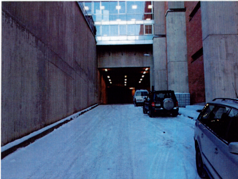
Figur 10 Tunnelmynning vid förrådsbyggnader.
