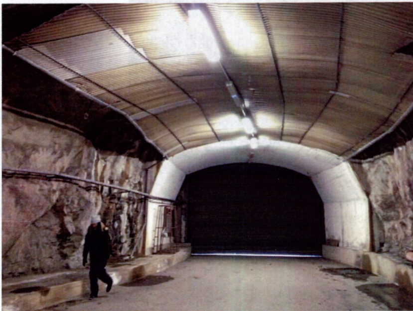
Figur 12 Tunnelmynning närmast rondell.
