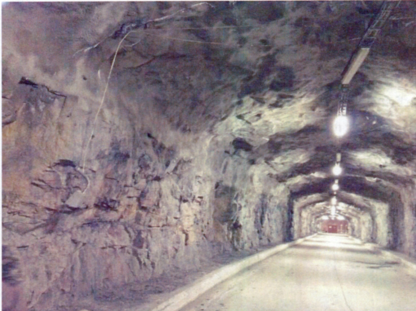
Figur 11 Tunnelrörets inre delar.
