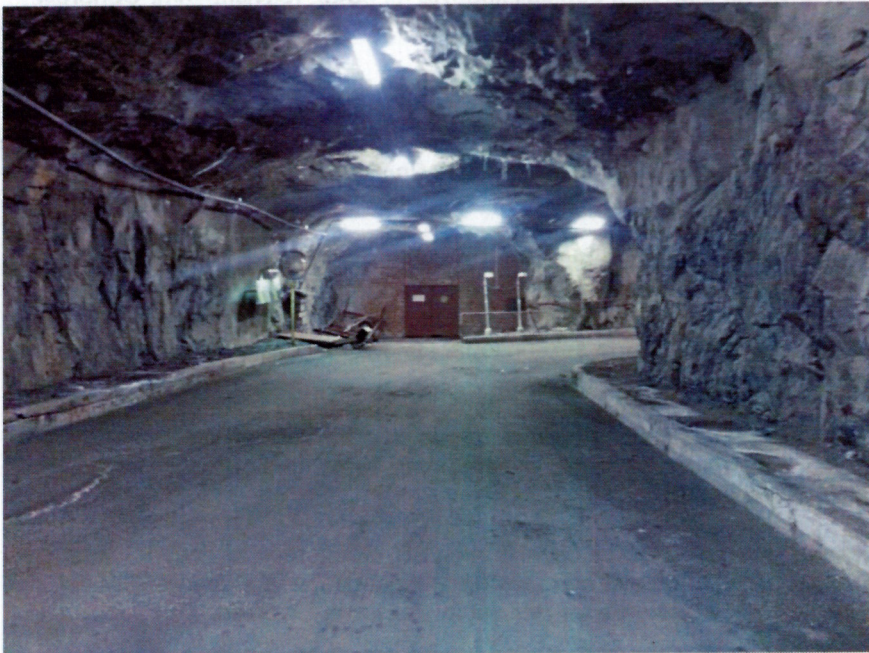
Figur 2 Den tvära kurvan mitt i tunneln sedd från den övre mynningen
