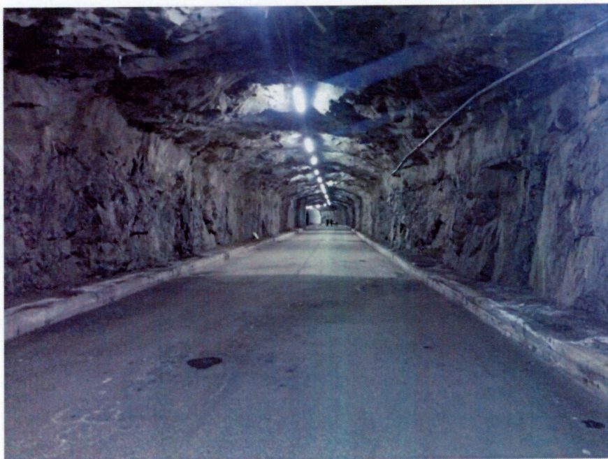
Figur 6 Vy upp mot den övre tunnelmynningen från kurvan. Gräns mellan asfalt- och betongbeläggning.
