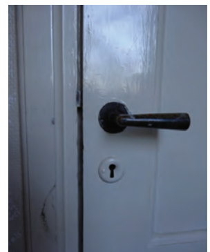
Dörrfoder, trycke och nyckelskylt av 1930-talstyp. Det nätta fodret har en liten profilering utmed ytterkanterna. I snickeridetaljerna har funktionalismen ännu inte blommat ut, vilket kan berätta om att huset befinner sig i ett arkitektoniskt brytningskede.
