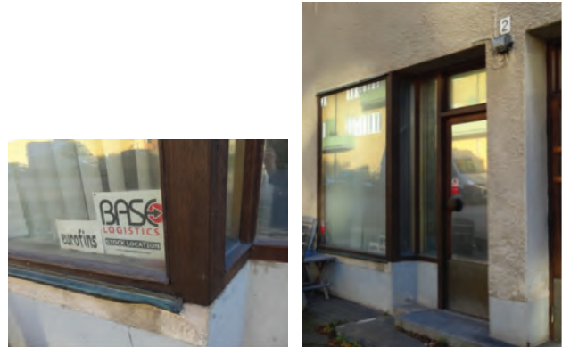
Detalj av butiksfönster i teak, till höger entrédörr och butiksfönster som går över hörn.
