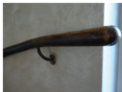
Trapphus i det äldre lamellhuset med svängda hörn. Även handledaren följer hörnets form. Till höger detalj av handledaren med mjuk avslutning och elegant väggfäste med profilerad plåtrossett.
