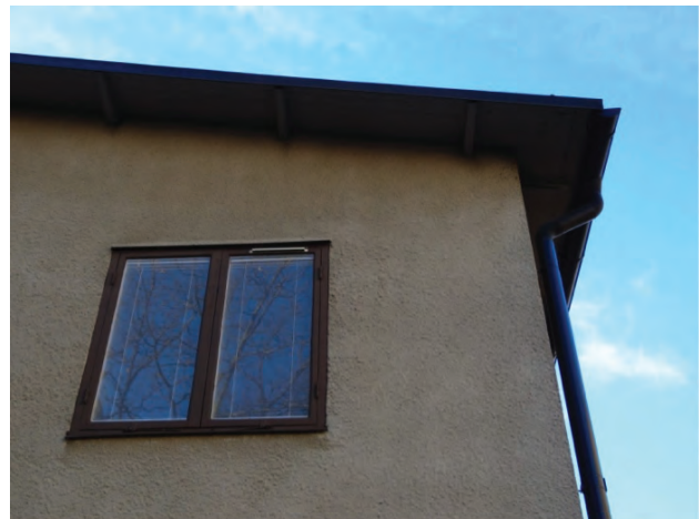
Detalj av fasad med utskjutande taksprång. Synliga taksparrar och tunna plåttäckningarna ger taket ett lätt uttryck. Nedanför ett tvåluftsfönster som ligger i liv med fasadytan. Från början var fönstren vita och fasaderna slätputsade i en ljusare kulör.
