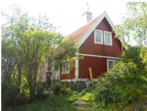
Vaktmästarbostaden strax norr om huvudbyggnaden. (Byggnad nummer 7)
