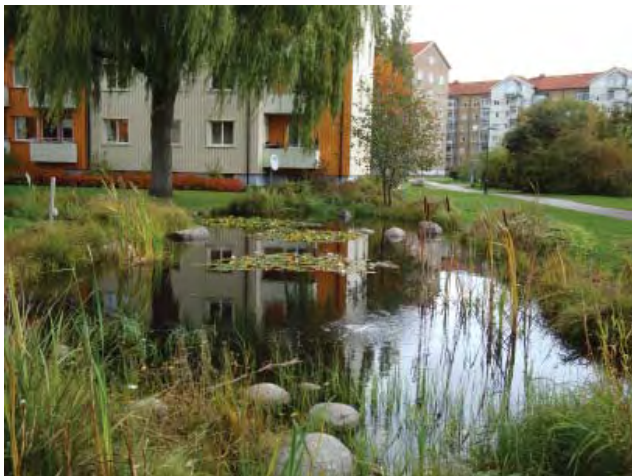
Dagvattenhantering med dagvattendamm, Sweco, dagvattengruppen
