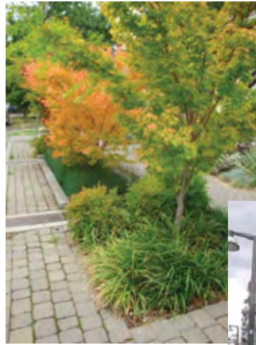
Dagvattenhantering med växtbäddar och regngårdar, Sweco, dagvattengruppen
