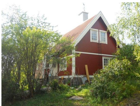
Vaktmästarbostaden strax norr om huvudbyggnaden. (Byggnad nummer 7)
