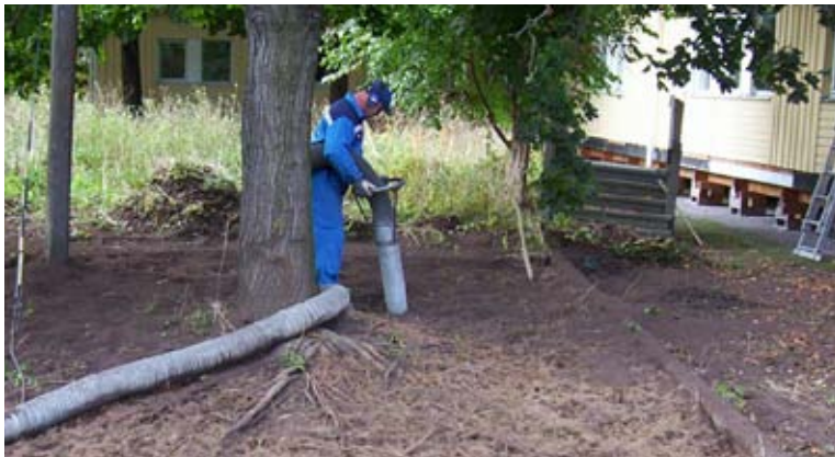
Rotvänlig schakt med vakuumsug. (Foto: Örjan Stål)
