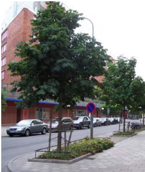
Nyanlagd gångbana med gatutråd i Stockholm. Träden har en underplantering av flocknavor. 15 m 3 skellettjord/träd och luftigt bärlager är lagd under den hårdgjorda beläggningen. Dagvatten från hustaken leds via skålförmade betongrännor till luftnings- och dagvattenbrunnar. (Foto: Björn Embrén)
