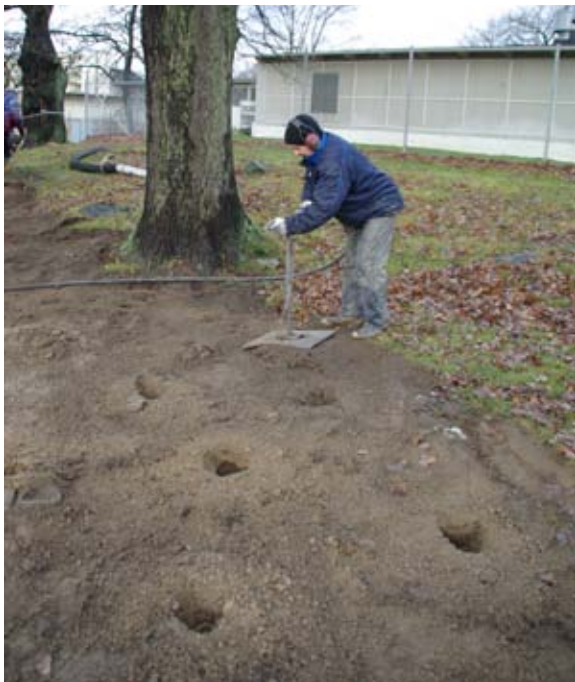
Luckring av kompakterad mark med hjälp av tryckluftslans. (Foto: Örjan Stål)
