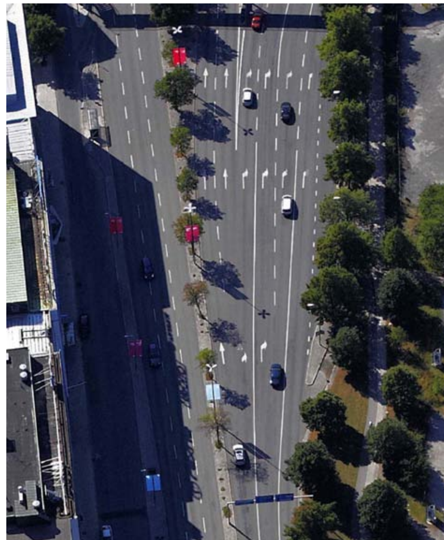
Flygbild av Norrtull, Stockholm 2007. Lindarna planterades samtidigt men har olika markförutsättningar. Skillnaden i utveckling mellan träd i hårdjord yta kontra träd med tillgång till vegetationsyta är slående. (Foto: Stockholm stad)
