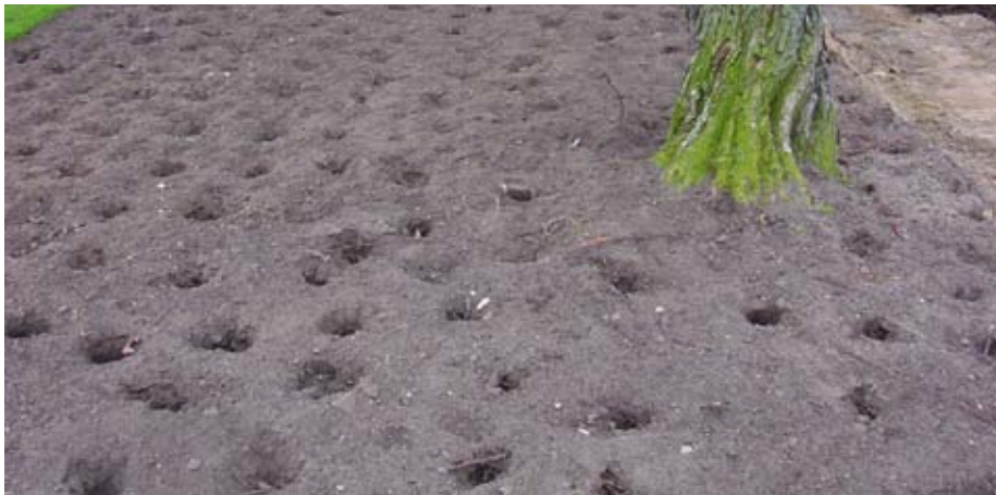
Tryckluftlans används dels för att skjuta loss jord vid rotvänlig schakt och dels för att luckra den gamla parkytan. Framschaktat rotsystem skyddas med utlagd växtjord. (Foto: Örjan Stål)
