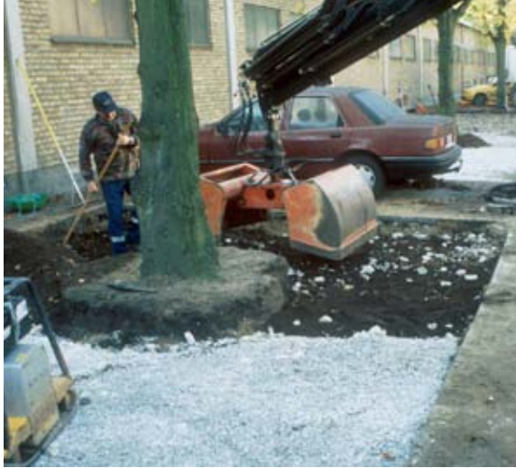
Färdigställande av parkering med luftig grusyta och låsande lager av makadam. (Foto: Örjan Stål)
