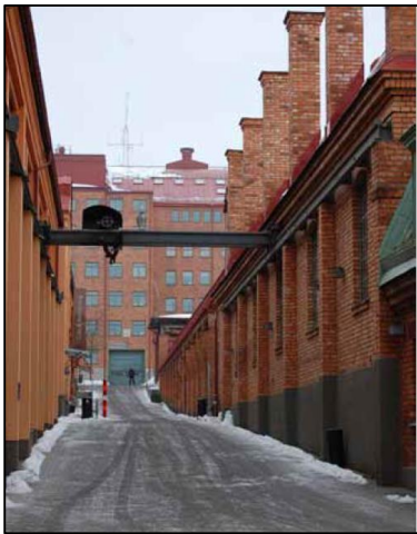
Delar av bevarad industribebyggelse.
