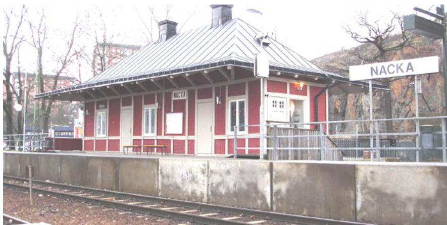
Stationsbyggnad vid Nacka station.
