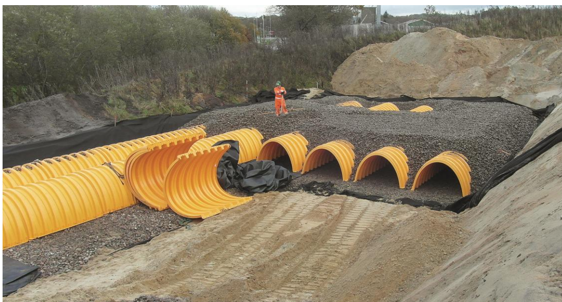
Figur 7. Exempel på utformning av magasin med Aquaton 4500 som kan placeras under eller i ramp, eller vid sidan av spåren, men inom spårområdet. Foto: Milstorm™.
