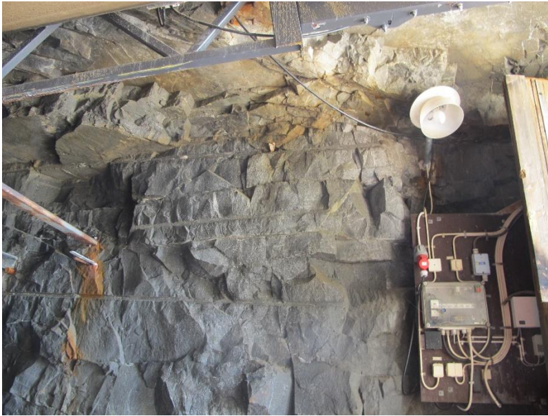
Figur 5 Högra väggen av tunneln
