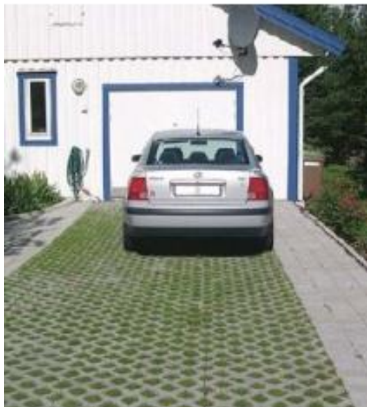
Figur 22 – Exempel på betonghålsten vilket vore lämpligt på planerade parkeringsplatser
