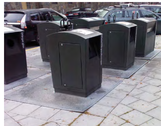
Referensbild, nedgrävda behållare för avfall
