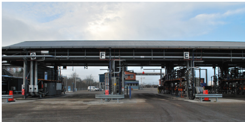
Påfyllningsplatsen på de stora terrassplanen i väster. Kontorsbyggnaden syns i bakgrunden.
