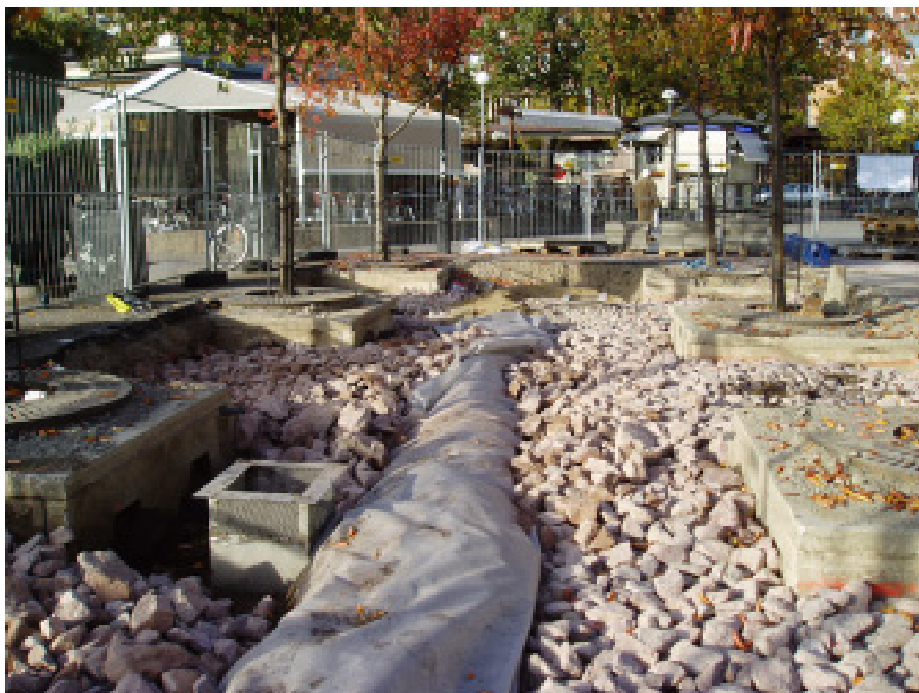
Luft- och dagvattenbrunn Clarova ställs på skelettskärven när man nått rätt nivå på skelettlaget.
