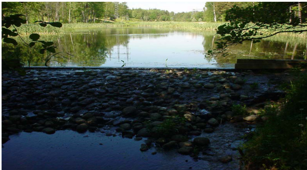
Anläggning för rening av dagvatten i Tyresö kommun
