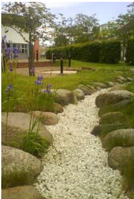
Figur 20. Exempel på stråk för fördröjning av dagvatten i form av grusbädd med omgivande gräs (Stockholm stad 2013).
