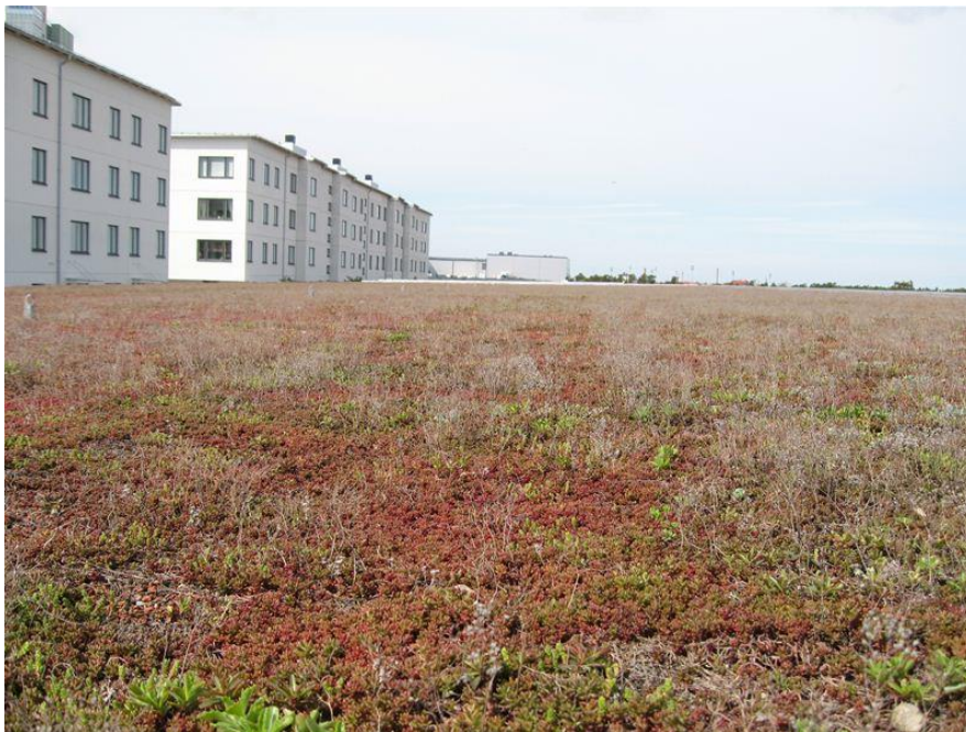
Figur 16. Sedumtak på Forum Nacka ( www.vegtech.se )
