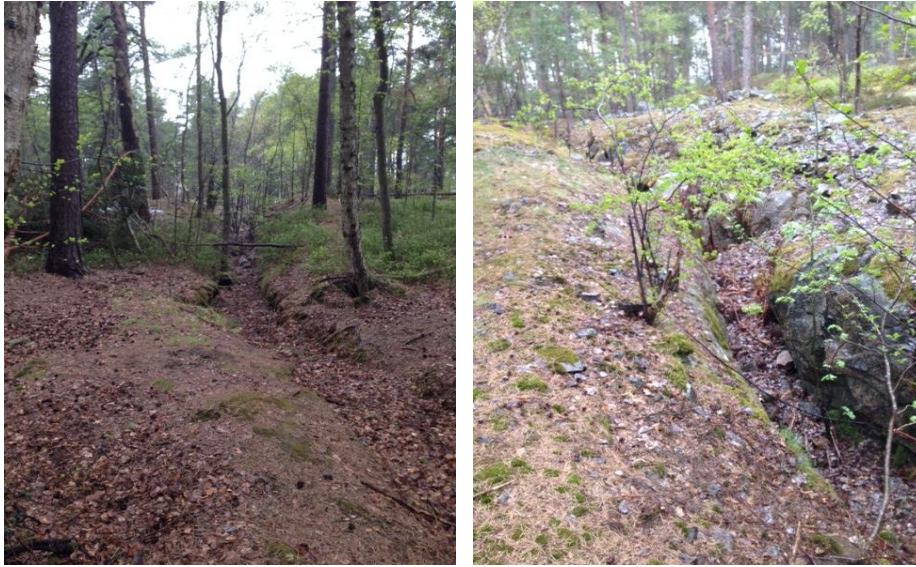
Figur 5. T.v. Dike som korsar lågpunktsområde 3. T.h. Diket genom lågpunktsområde 3 fortsätter genom berg vilket skapar en kanal mot Svindersviken.
