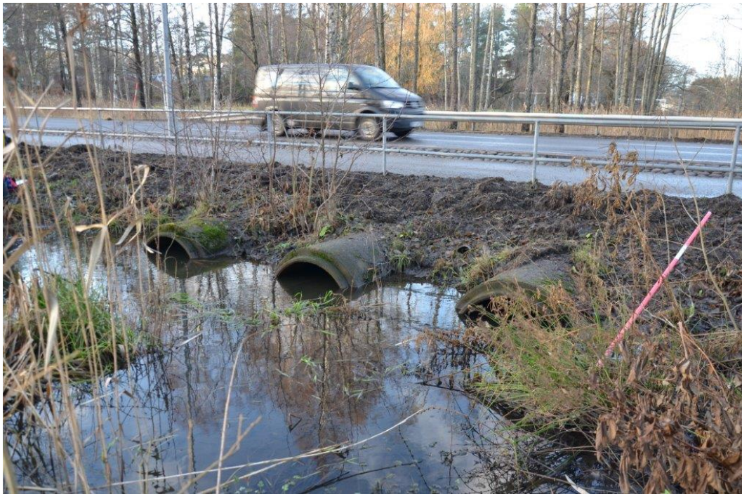
Figur 5:12. De tre utloppsörens från våtmarken under Ältavägen. Flödesriktningen är in i bilden som är tagen den 8 december 2017.
