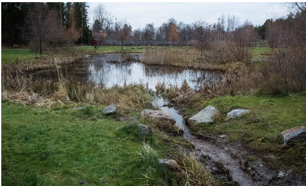
Figur 5:7. Damm för rening av dagvatten i ett utströmningsområde för grundvatten. Fotografiet är taget den 8 december 2017. Platsen för fotografiet visas i figur 5:5.
