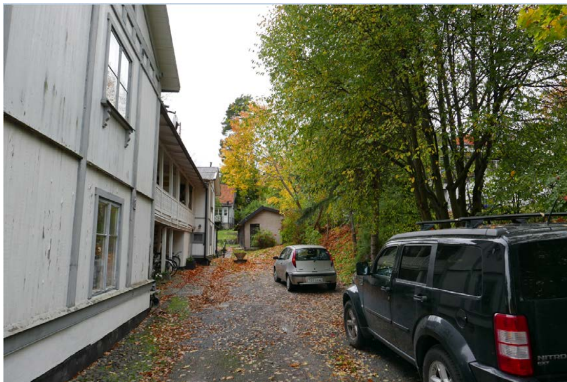
Parkering och angöring till Långa raden sker via infart från Strandpromenaden. Långa radens norra fasad ses på bilden.
