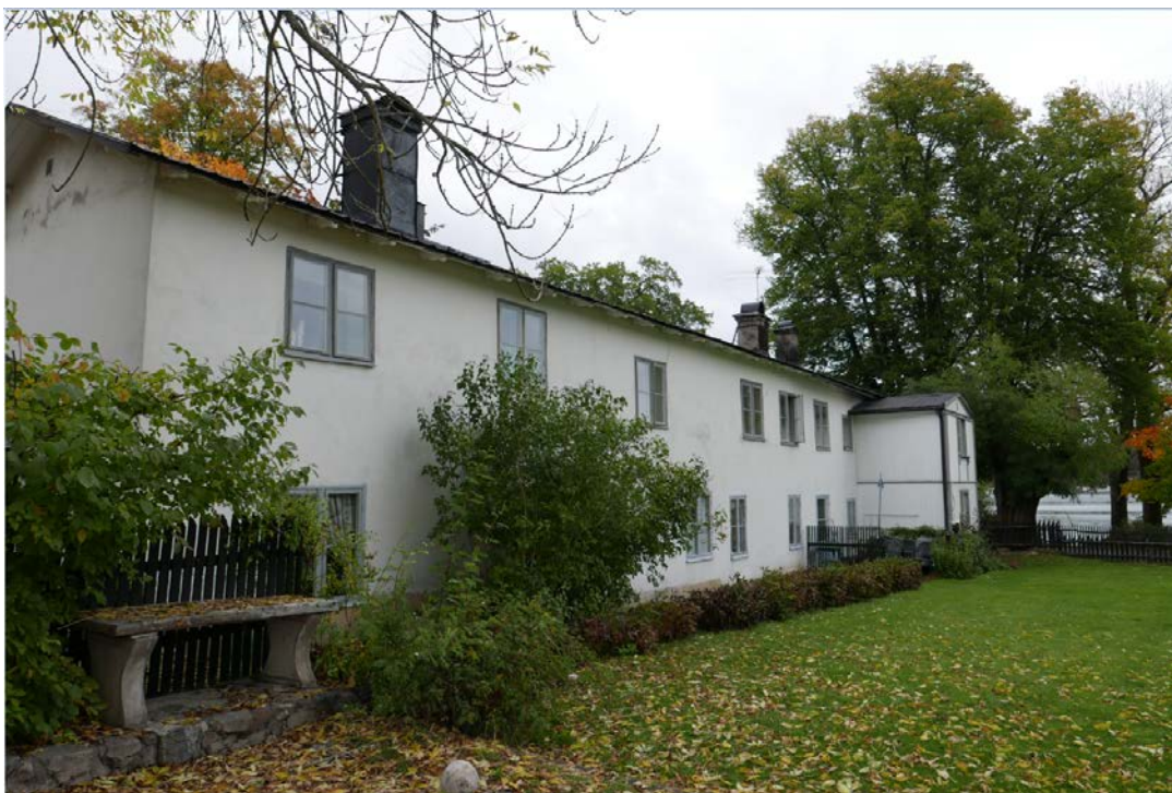
Bilden visar Långa radens södra fasad.
