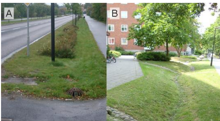
Figur 11 - A) Anlagt svackdike vid Sockenvägen i Stockholm. B) Svackdike i Augustenborg i Malmö (Bild: Sweco).
