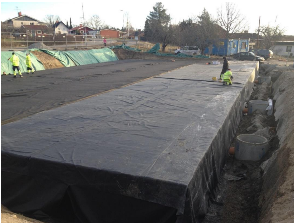
Figur 19 Anläggning av fördröjningsmagasin med plastkassetter
