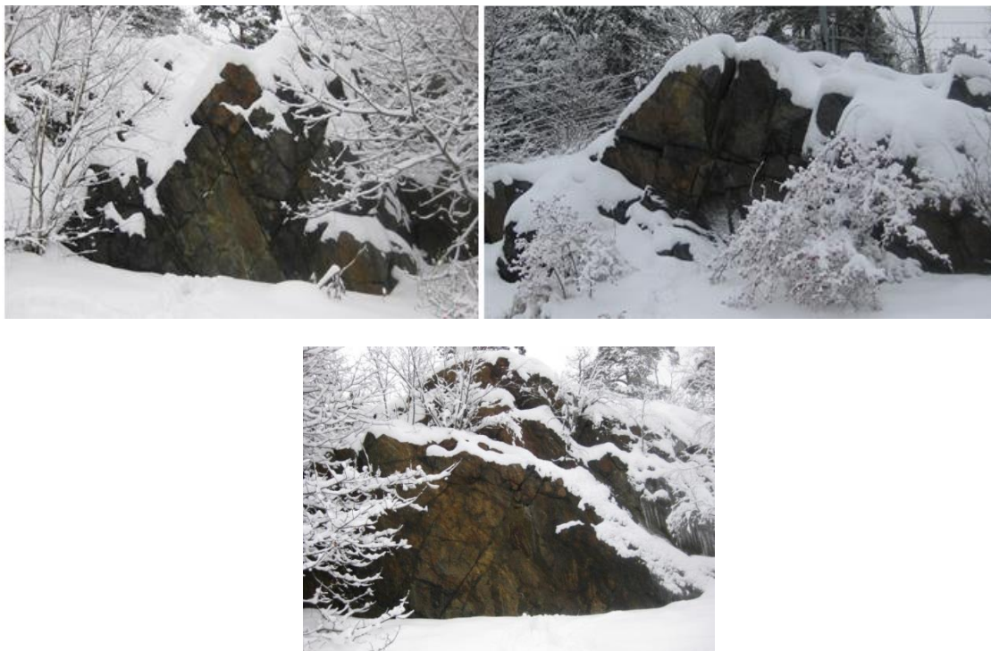
Figur 3. Sydlig bergskärning längs Värmdöleden. Berget är ställvis blockuppsprucket i tre till fyra sprickriktningar.
