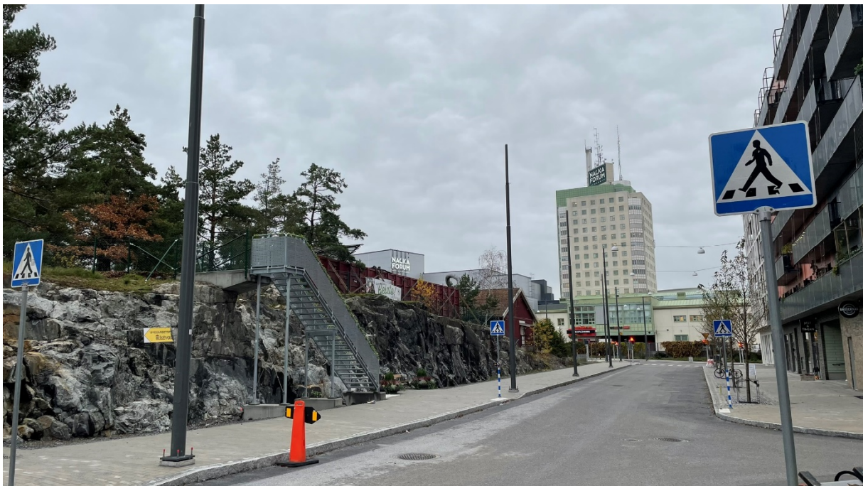
Figur 7: Bild som visar planområdet idag mot Tor Boijes gata. Till vänster syns sprängkanten och den tillfälliga trappan upp till stadshusområdet. I fonden syns Nacka Forum vid Vikdalsvägen. (Foto: Nacka kommun)
